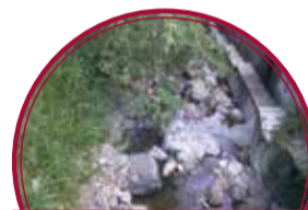
Construcción puente vehicular sobre la quebrada Malpaso entre carrera 80 y calle 92 y obras complementarias $3.872 millones
