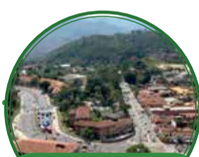
Ampliación de la carrera 80 - 81, tramo 1 $6.000 millones
