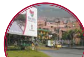
Ampliación de la avenida 80 entre las calles 77BB y 80 y obras complementarias $11.800 millones
