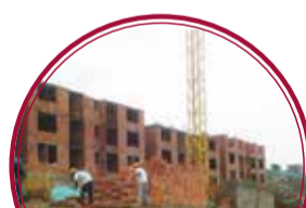
Pelicanos - 1.247 viviendas $42.090 millones
